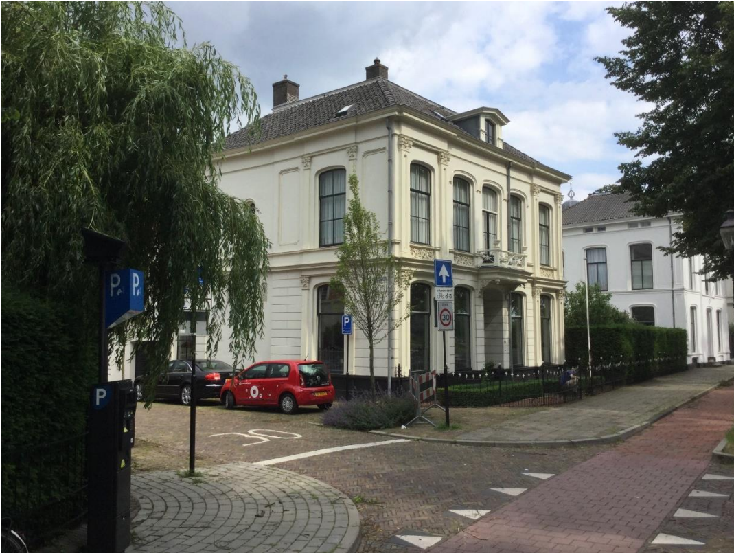
Afb. 23. Voorgevel en noordelijke zijgevel.
