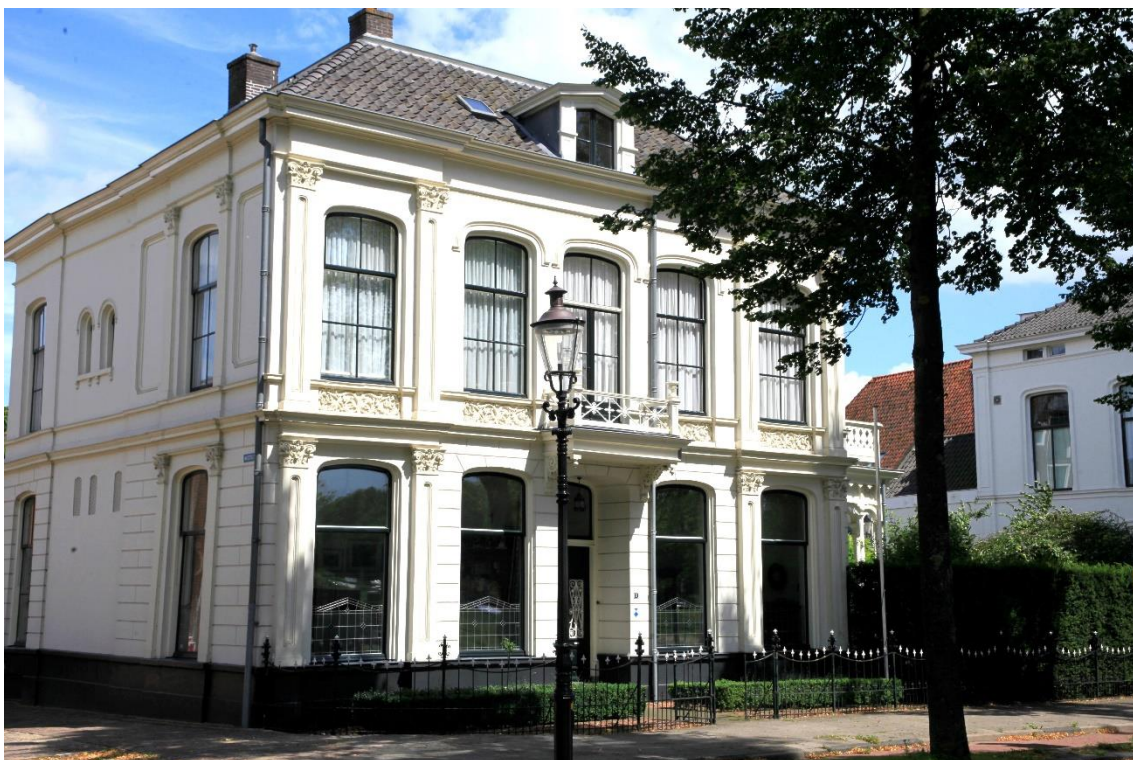
Afb. 20. De voorgevel. De huidige staat van het gebouw toont veel overeenkomsten, maar ook een aantal verschillen met de overgeleverde tekeningen.
