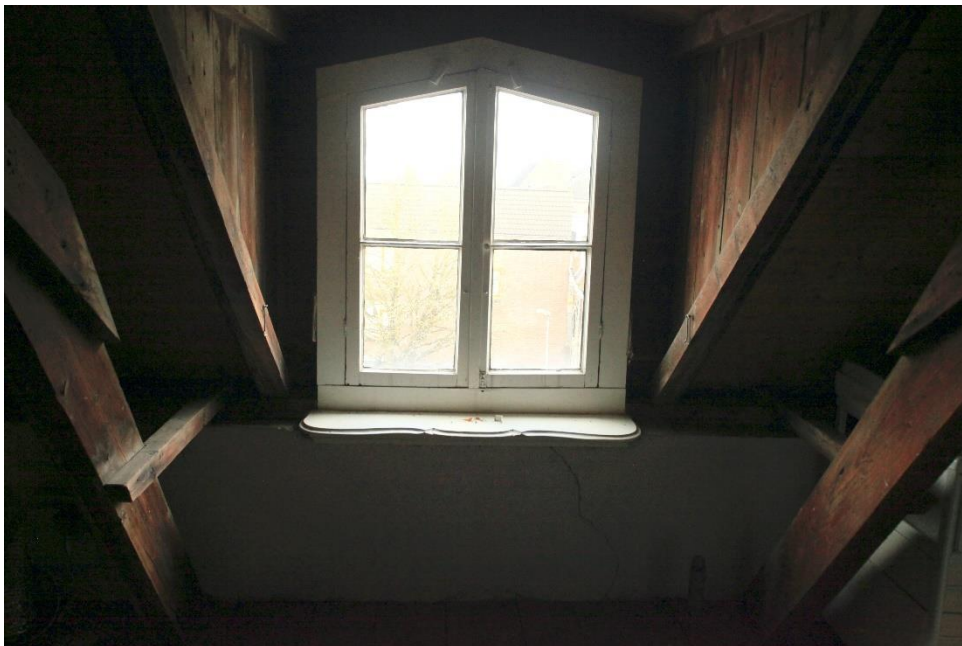
Afb. 109. De dakkapel aan de oost(achter)zijde.
