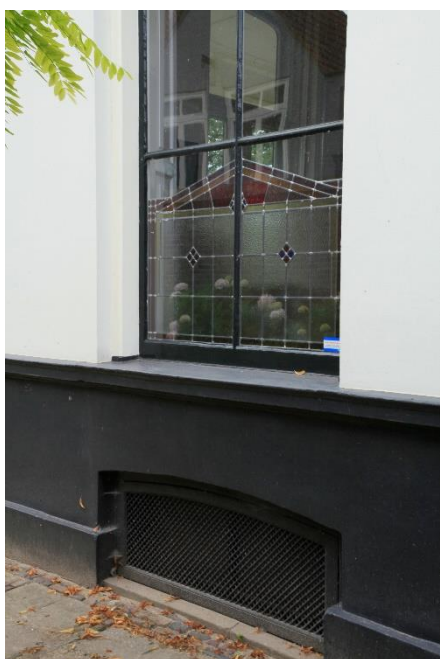
Afb. 40. Detail van de achtergevel met kelderlicht.
