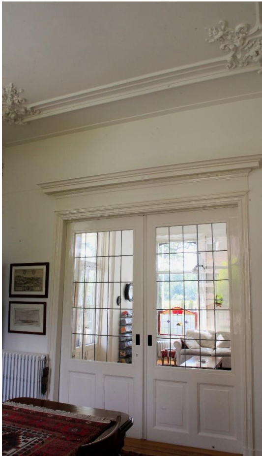
Afb. 68. Schuifdeuren in de kamer-en-suite.
