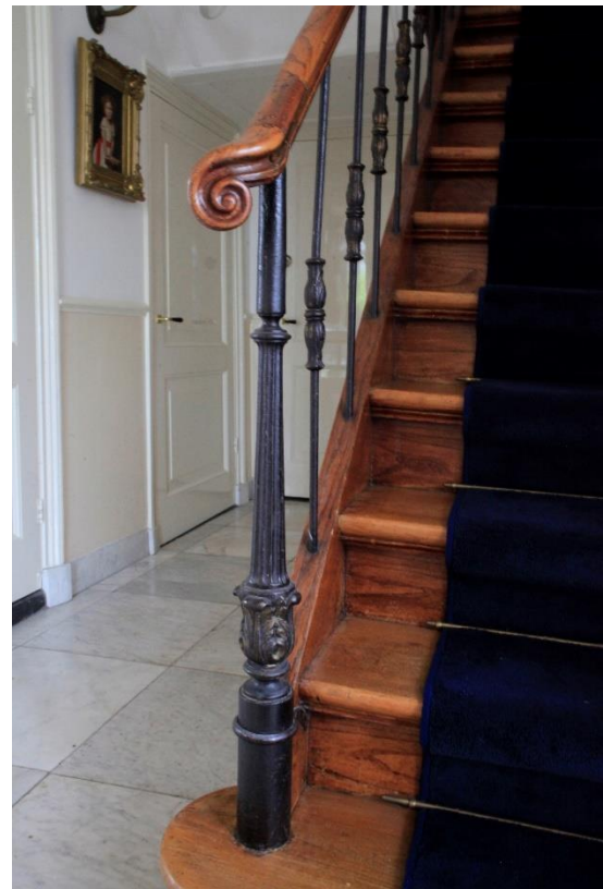
Afb. 63. Trap met trappaal en bloktrede.
