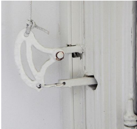
Afb. 53/54. Deurbelmechaniek voorzijde.
