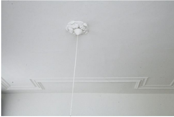
Afb. 94. Plafondrozet eerste verdieping slaapkamer 2.
