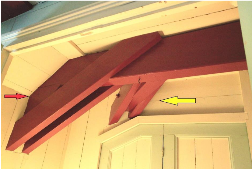
Afb. 120. Dakconstructie in de bedstede.
