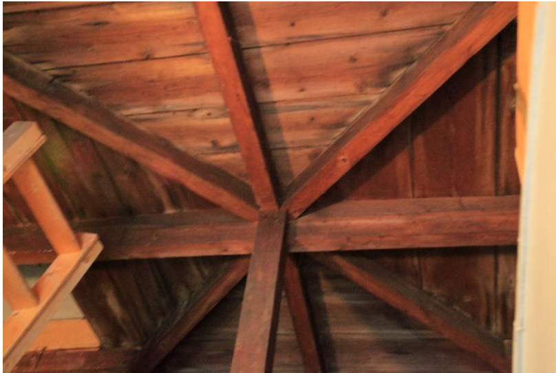
Afb. 106. Midden van het dak.
