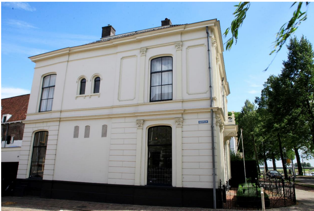
Afb. 27. Zijgevel noordzijde aan het Muggeplein.
