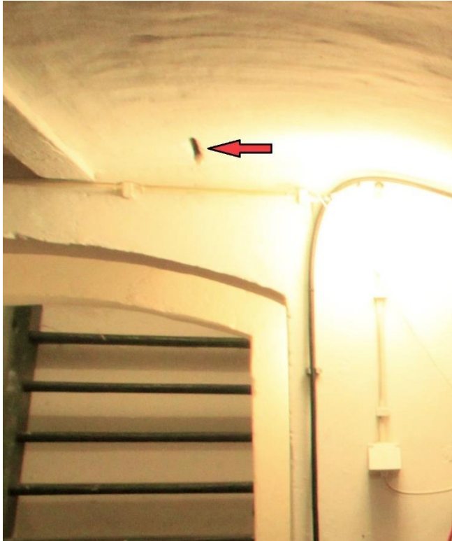
Afb. 47. Kelderdeel C onder de achterkamer, richting noord.
