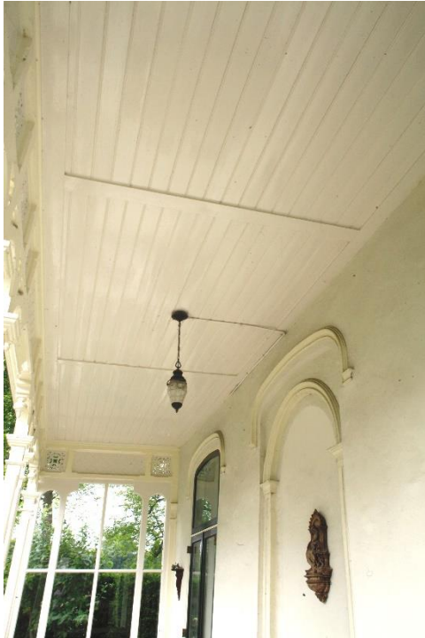
Afb. 36. Het plafond is gemaakt van schroten, de zijden van de veranda zijn tegen de wind gedicht met glaspuien.
