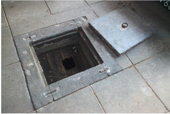
Afb. 83. Ingang van de waterput met deksel en ring.
