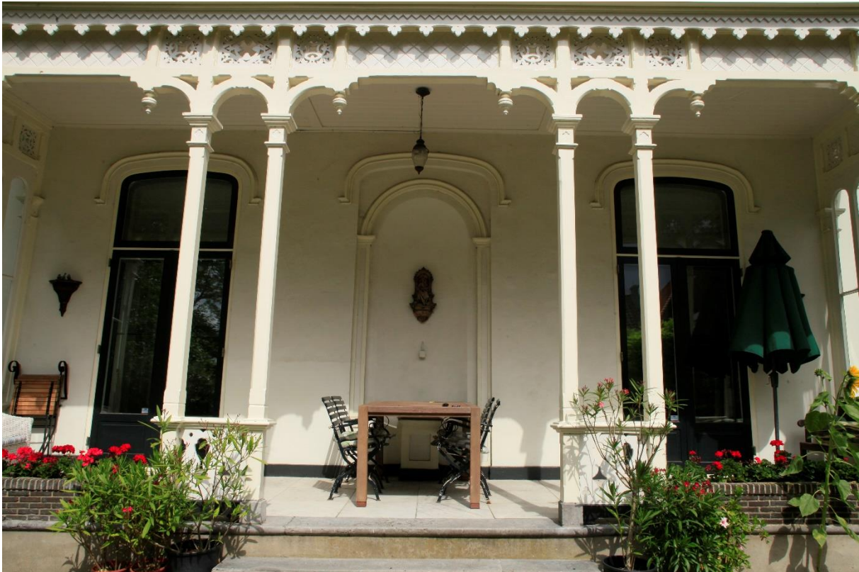
Afb. 33. De centrale plek in de veranda: in een blindvenster, dat van gelijke grootte en vorm is als de belendende deuropeningen, zien we een booglijst die op twee kleine pilasters rust.
