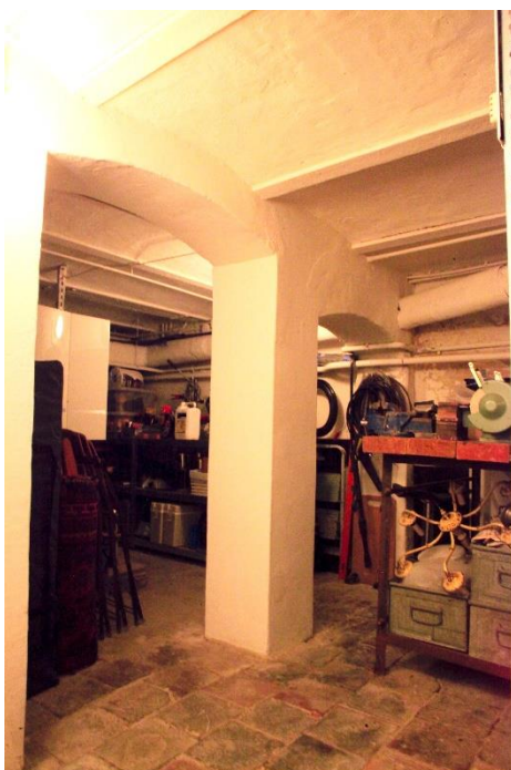
Afb. 46. Deel van de kelder onder de keuken.
