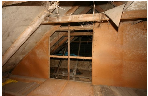
Afb. 30. Wand tussen hoofdgebouw en uitbreiding op de verdieping.
