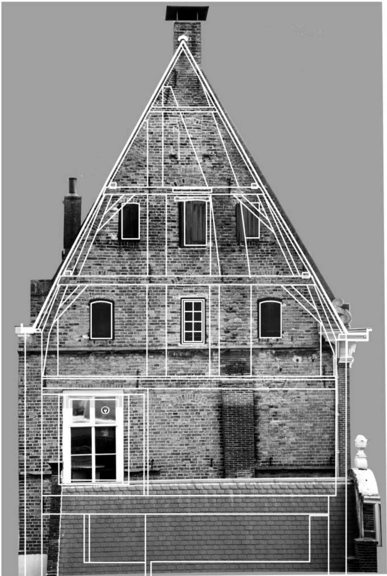
Afb. 7. Linker zijgevel. Uit deze montage blijkt dat de kapconstructie past op de kopgevel, en dus dat ze uit dezelfde tijd zijn.
