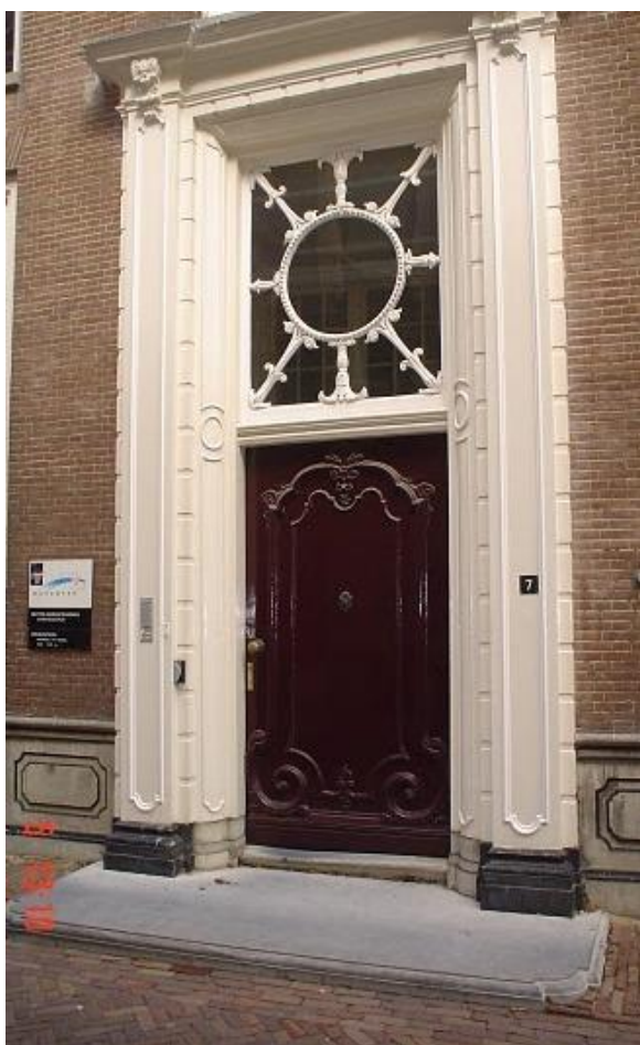
Afb. 5. Deur met omlijsting, versierde plint en snijraam.
