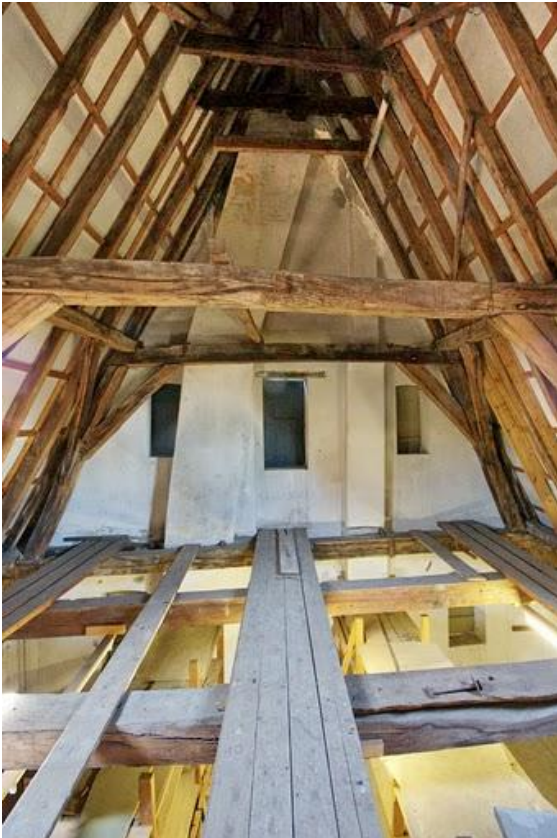
Afb. 26. Kap vanaf de vloering.
