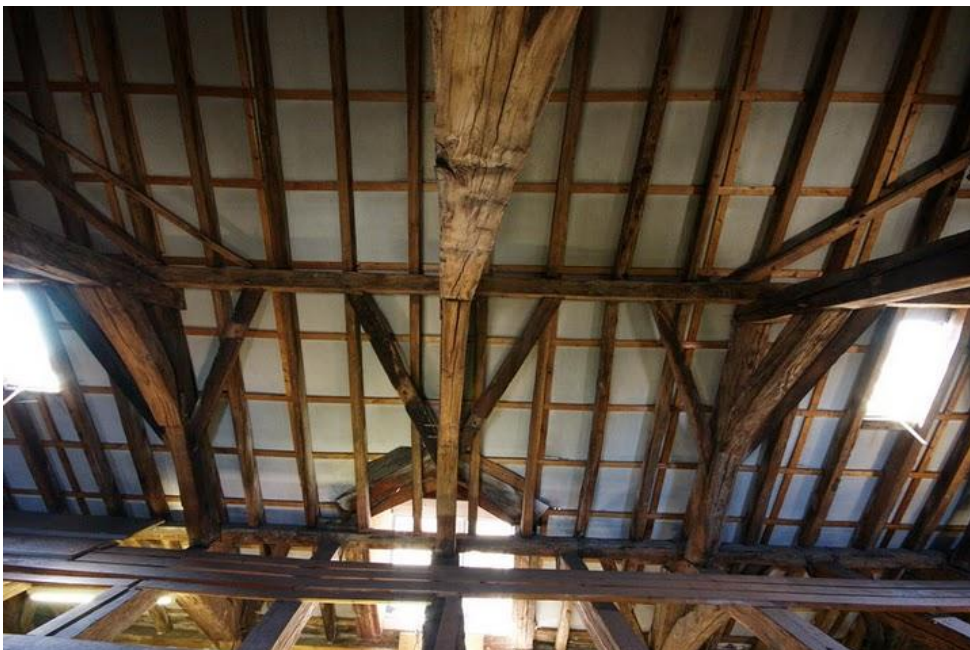
Afb. 25. Spanten op vlieringniveau.
